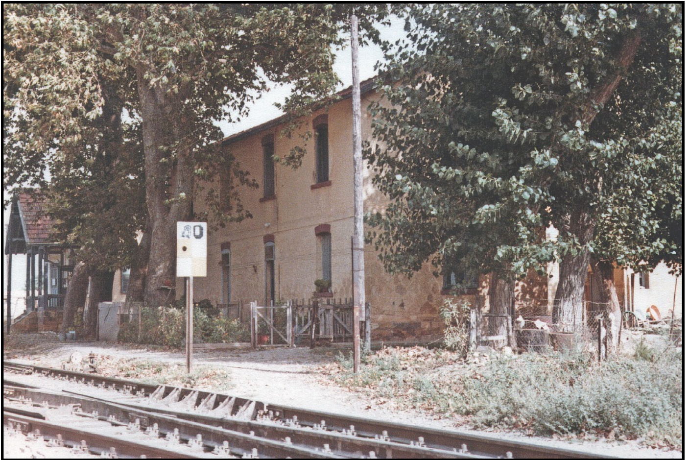
Τέρμα Εθν. Αντίστασης (νυν Η' παιδικός σταθμός)
